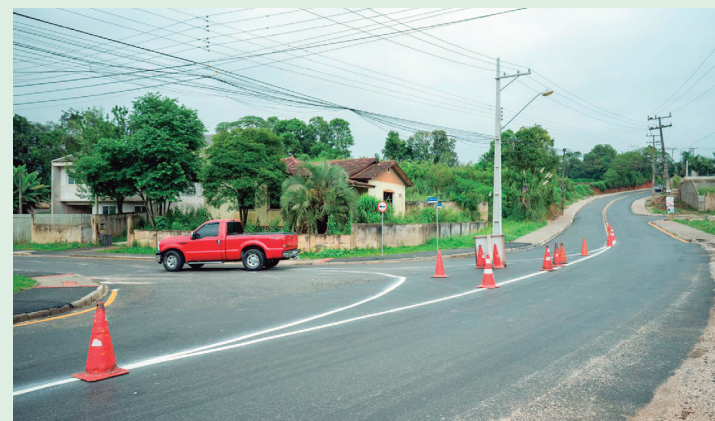
Prefeitura implanta binário no trecho inicial da Rua Orlando Ceccon.
