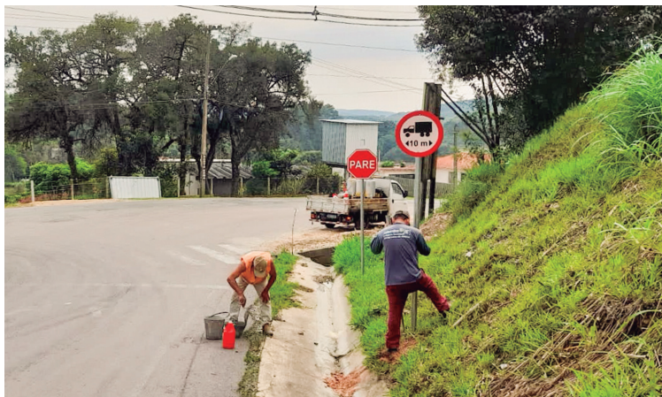
O tráfego de caminhões com comprimento de até 10 metros de comprimento não será permitido; a ação deve-se às obras de revitalização que acontecem na via pública.
