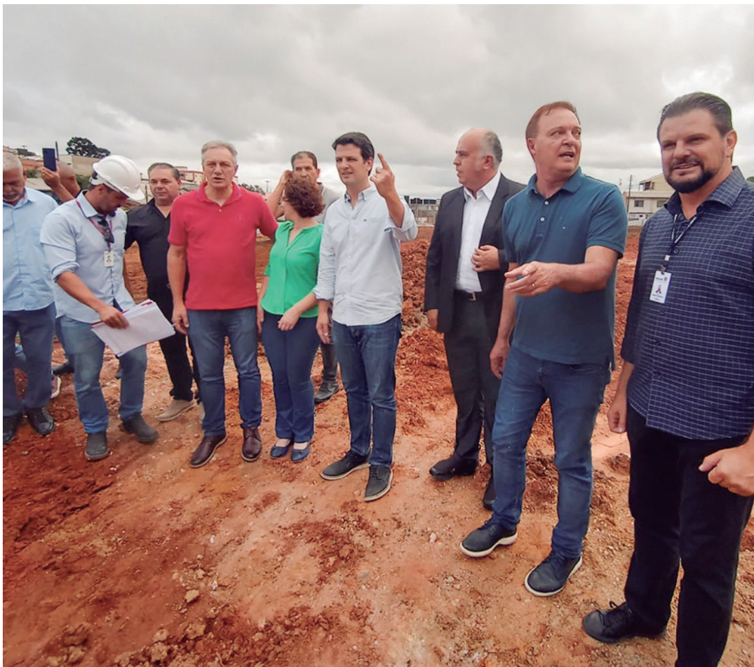
Equipe responsável pela execução da obra apresentou detalhes do andamento aos secretários Eduardo Pimentel e Cesar Neves.
