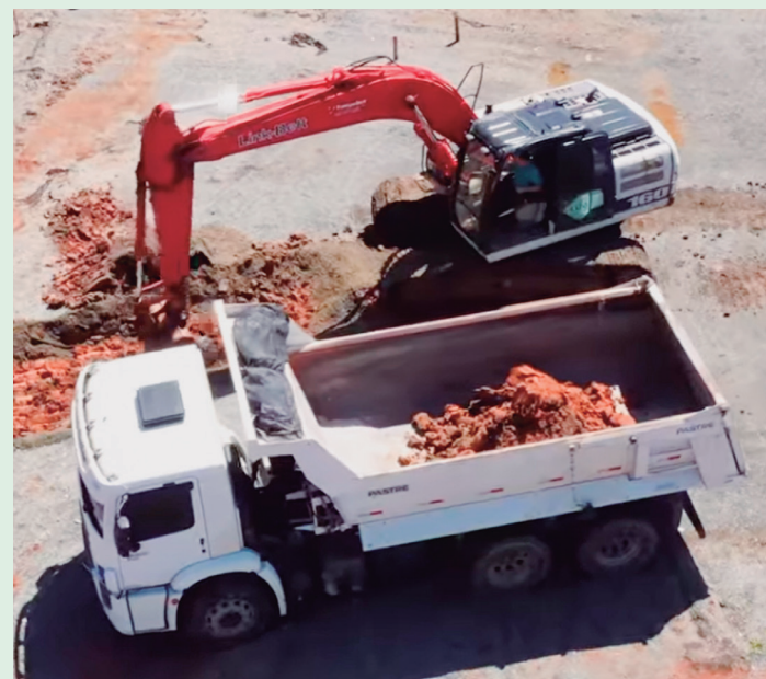
Obra está sendo executada em uma área de 13 mil metros quadrados no Jardim Monza. Serão cinco pavimentos, além de área técnica.
